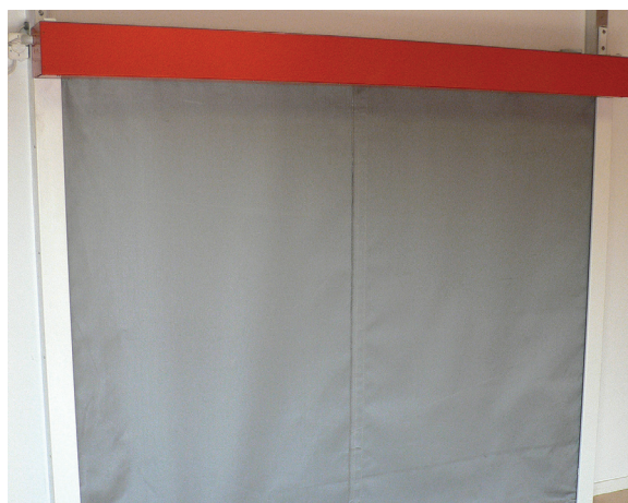
Automatisk rökgasgardin i neddragen position
