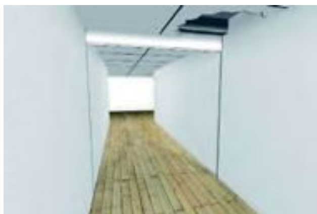
Dolt montage av kassett och geider i korridor.
