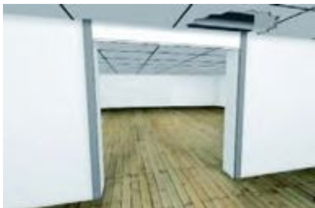
Montage av kassett ovan undertak och montage av geider på vägg.
