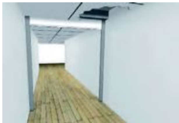
Dolt montage av kassett i korridor och synliga geider på vägg.
