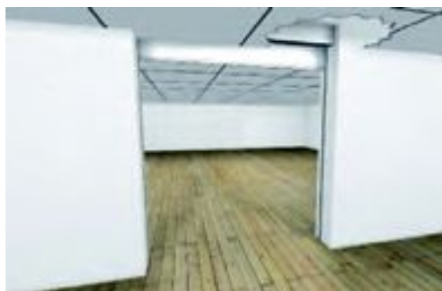
Dolt montage av kassett ovan undertak och geider i dagöppning.
