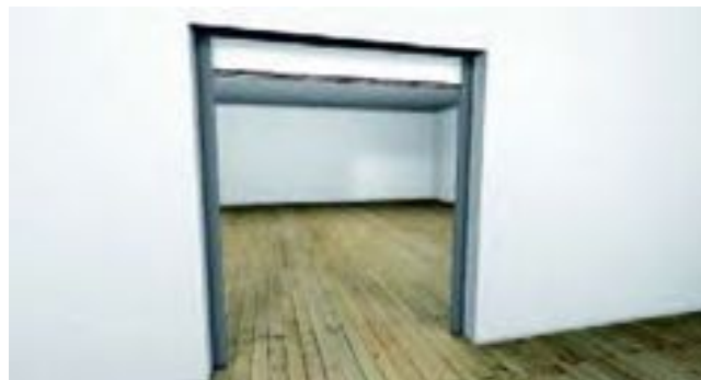
Synligt montage av kassett och synligt montage av geider i en dagöppning.
