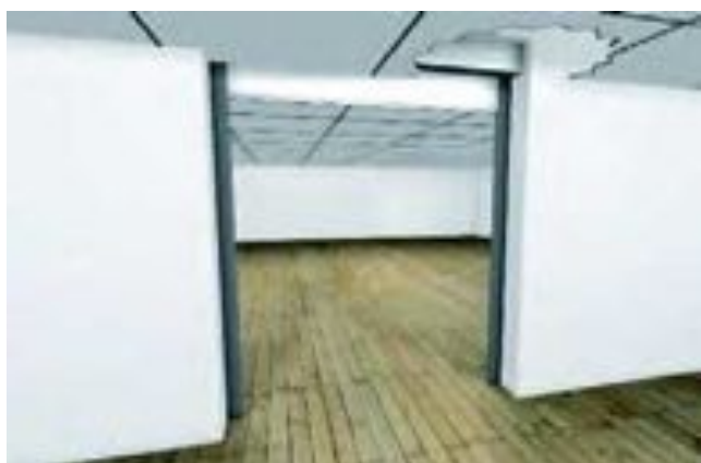
Dolt montage av kassett ovan undertak och synligt montage av geider i dagöppning.
